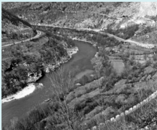
Lokacija za elektrarno Solkan pred pričetkom gradnje
