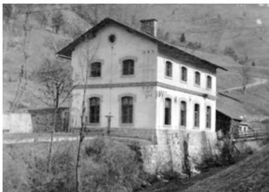
Strojnica elektrarne Pečnik v Spodnji Idriji pred letom 1926
