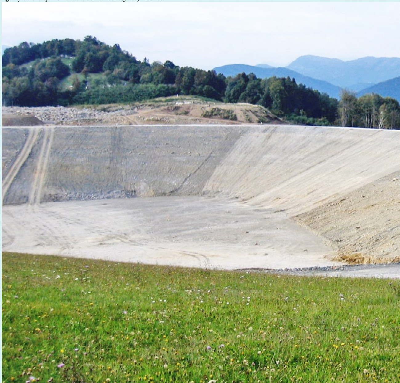
Zgornji bazen črpalne hidroelektrarne Avče v gradnji leta 2007
