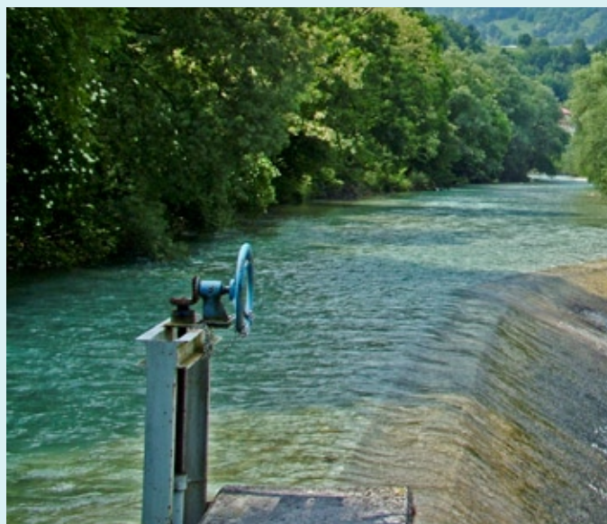
Preliv na pregradi elektrarne Tolmin
