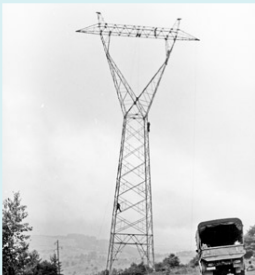
Montaža stebra za 400 kV omrežje okrog leta 1977
