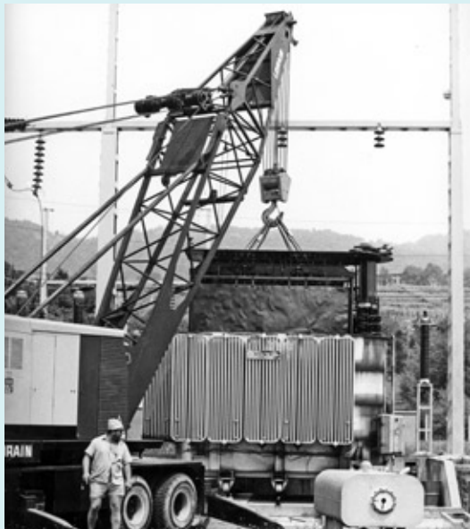
Popravilo transformatorske postaje Gorica v sedemdesetih letih
