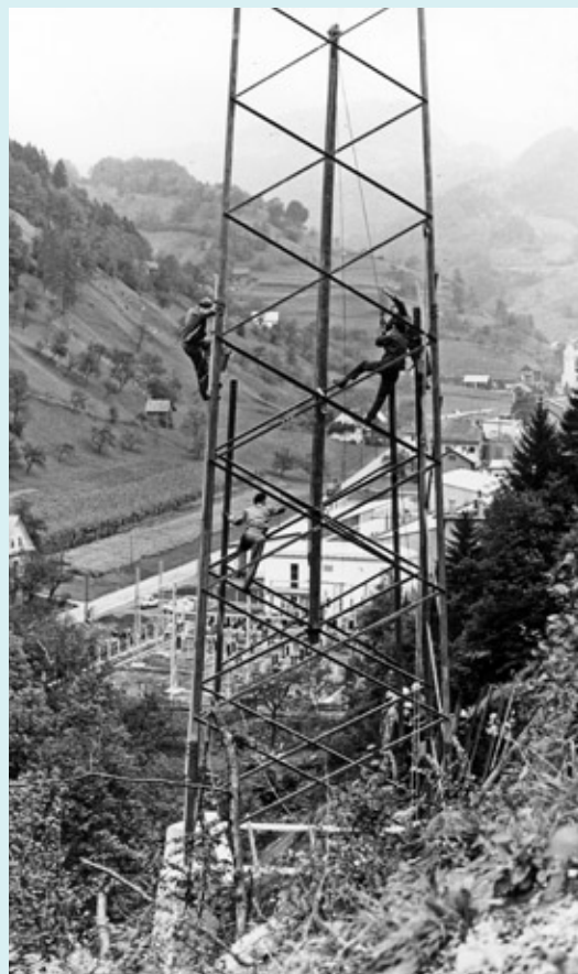
Gradnja razdelilne transformatorske postaje Cerkno leta 1972
