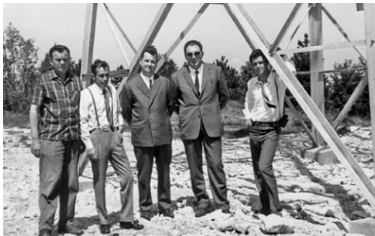
S kolegi iz razdelilne transformatorske postaje Padriče leta 1970 (na sredini tehnični direktor Avgust Batič)
