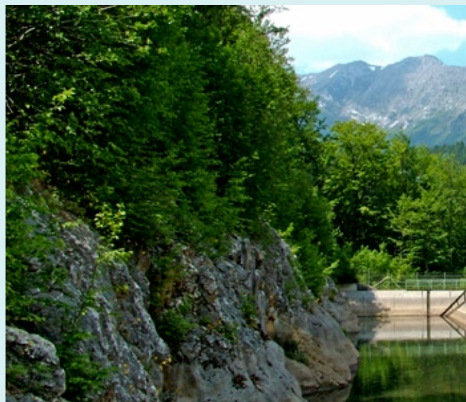
Bazen elektrarne Bača
