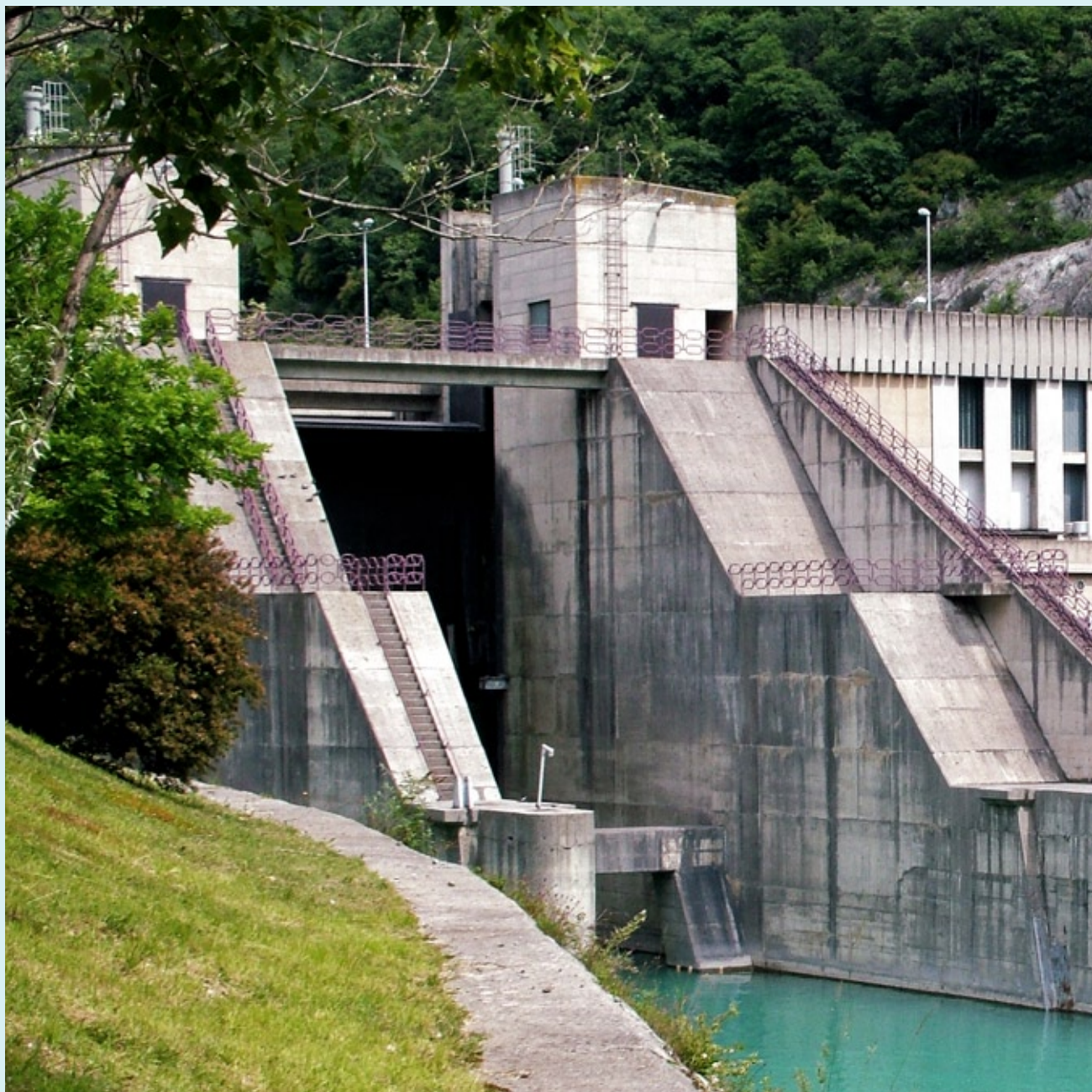
Elektrarna Solkan, pogled od spodaj
