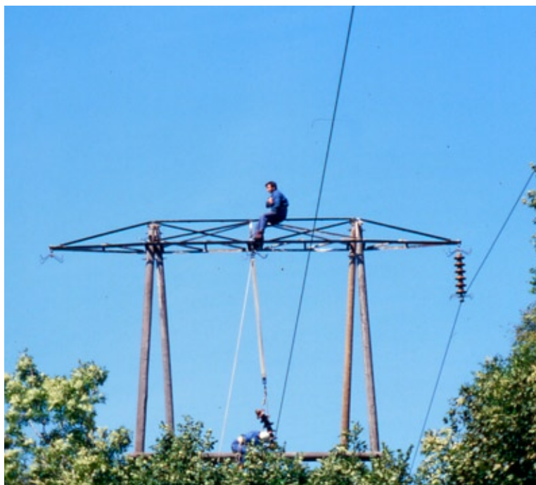
Podiranje lesenega daljnovoda med Doblarjem in Cerknim leta 1981
