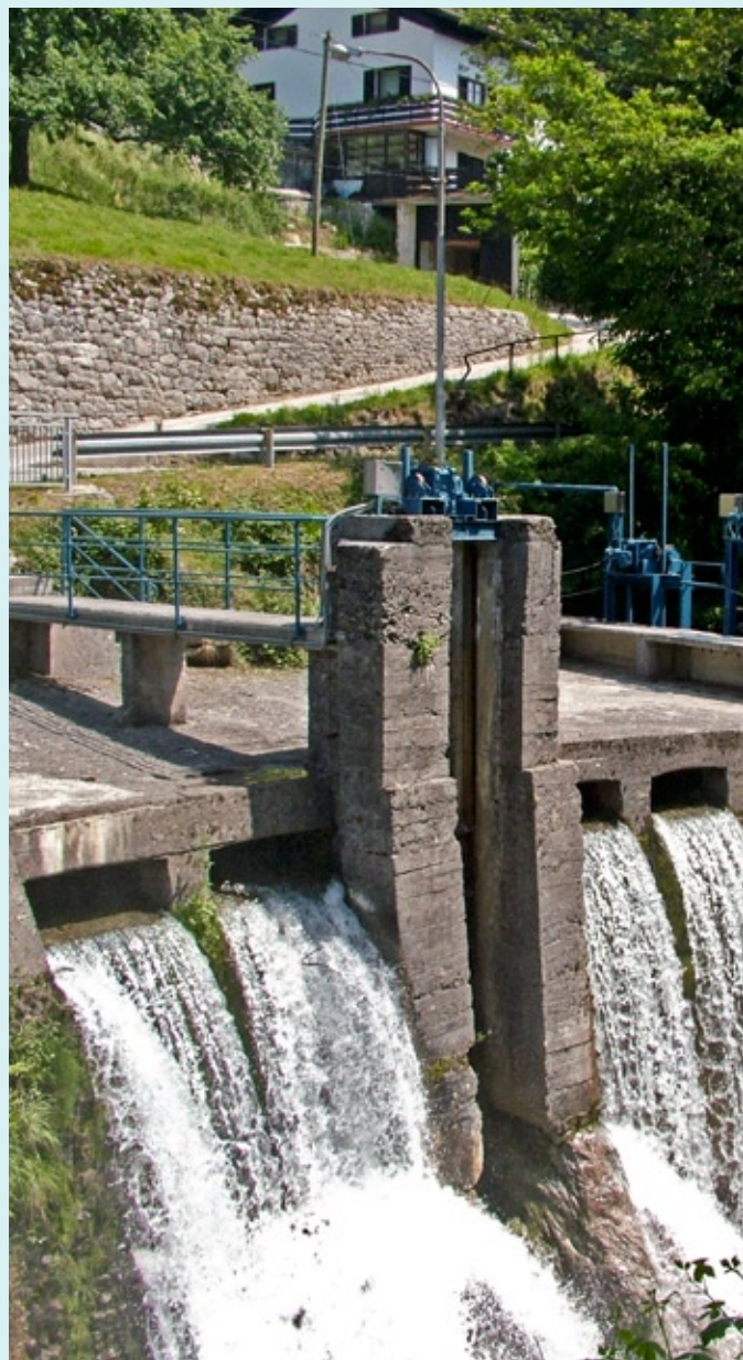
Preliv na pregradi elektrarne Podmelec
