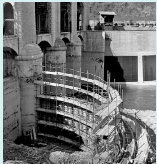
Gradnja elektrarne Ajba okrog leta 1972
