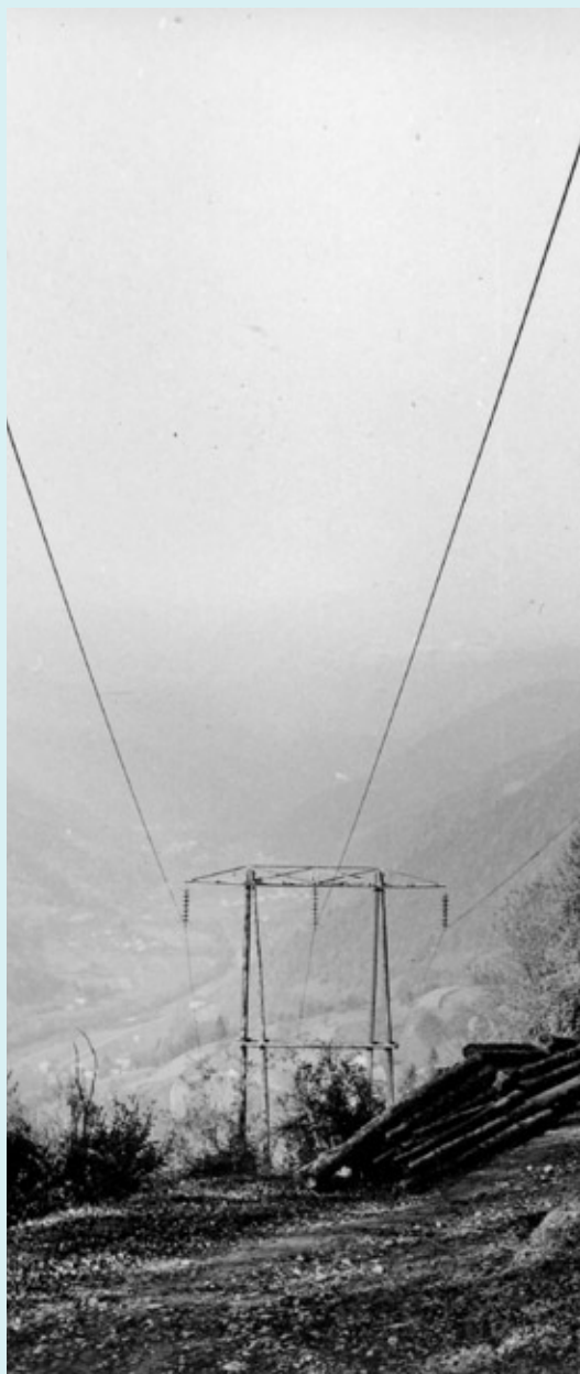
110 kV daljnovid Doblar - Kleče, zgrajen leta 1949 na lesenih drogovih
