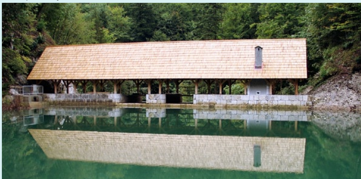
Kanomeljske klavže po obnovi leta 2005
