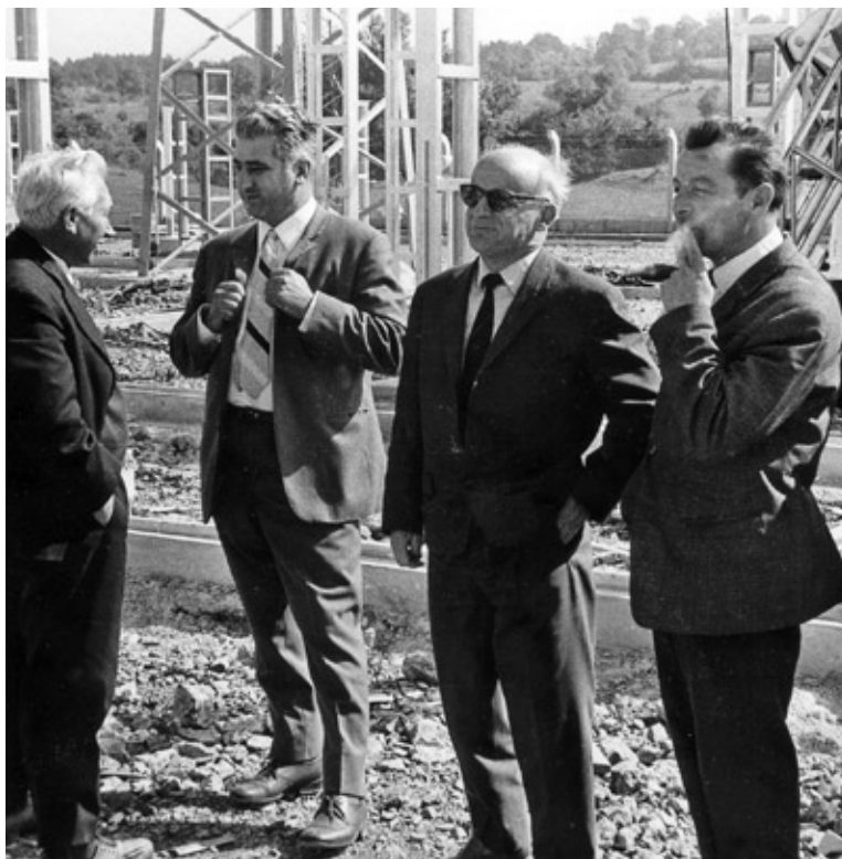
Na gradbišču razdelilne postaje 220 kV v Divači leta 1969
