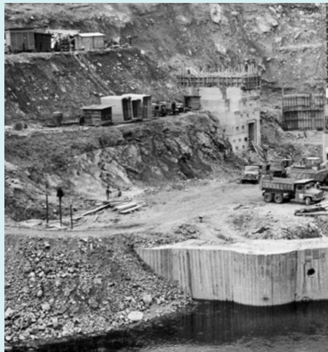
Elektrarna Solkan med gradnjo (prva gradbena jama) leta 1980
