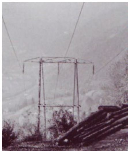
110 kV daljnovod Doblar - Kleče
