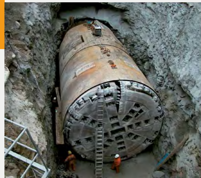
Vrtalni stroj TBM (tunnel boring machine)
