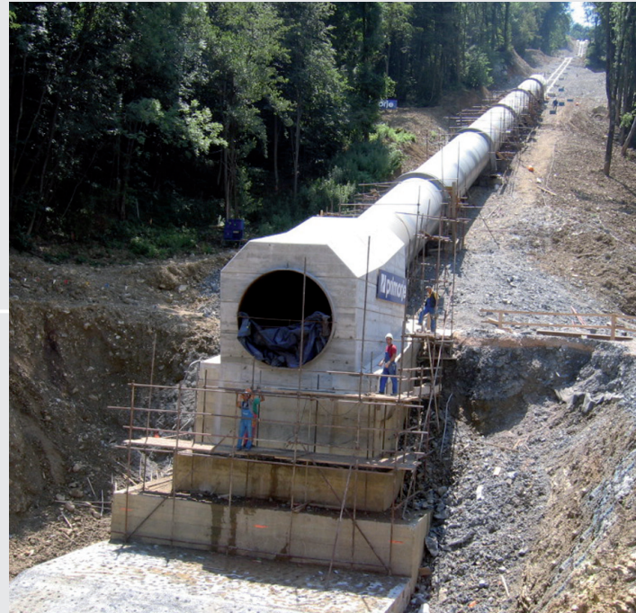
Tlačni cevovod – med gradnjo
