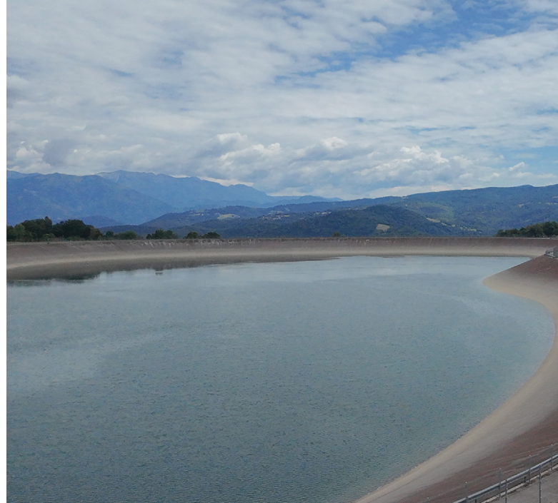
Zgornji bazen ČHE Avče in sončna elektrarna.
