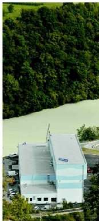
Ob jezeru Ajba je strojnica jaškastega tipa z reverzibilnim agregatom turbina - črpalka.
