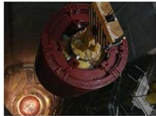
Spuščanje rotorja v jašek, maj 2009. Foto: Soške elektrarne
