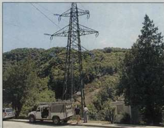
Povsem obnovljen, 1,8 kilometra dolg daljnovod Dobljar-Avče so po natančnem strokovnem pregledu včeraj vključili v elektroenergetski sistem
