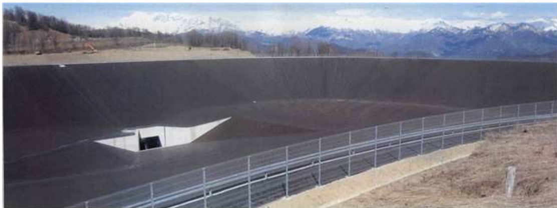
V zgornji bazen na Kanalskem vrhu bo mogoče načrpati 2,2 milijona kubičnih metrov vode
