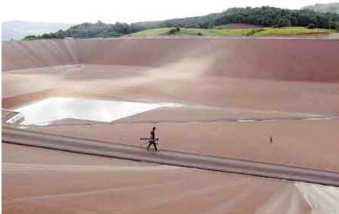
Med prvimi vidnimi znaki, da je ČHE Avče začela delovati, bo prav gotovo napolnjeno akumulacijsko jezero na Kanalskem Vrhju. Zdaj je še prazno, na dnu s posebno asfaltno prevleko zaščitenega bazena je le nekaj vode, ki se je nabrala ob zadnjih padavinah. (Rosana Rijavec)
