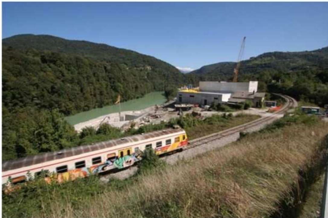
Gradnja črpalne hidroelektrarne Avče (Foto: Dare Čekeliš)
