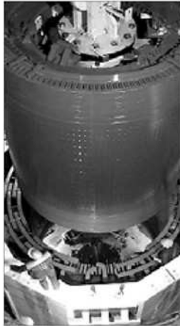
Nameščanje rotorja
