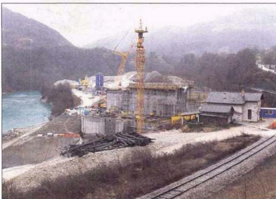
Dela na strojnični zgradbi bodoče ČHE Avče se nadaljujejo
