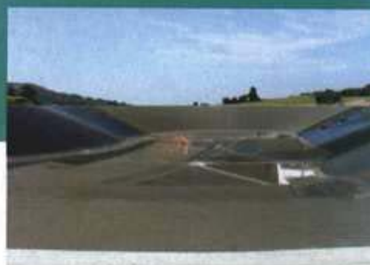
Asfaltiranje zgornje akumulacije
