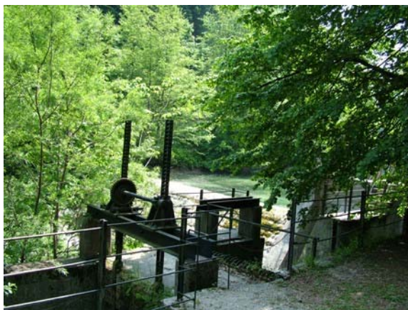
Slika 4: Zapornice
