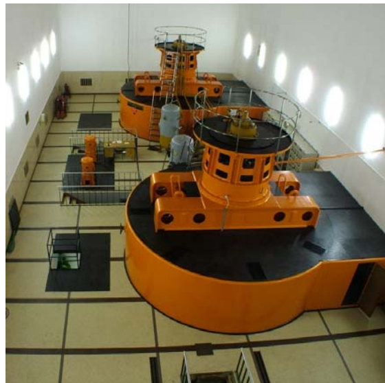
Slika 2: Notranjost strojnične zgradbe
