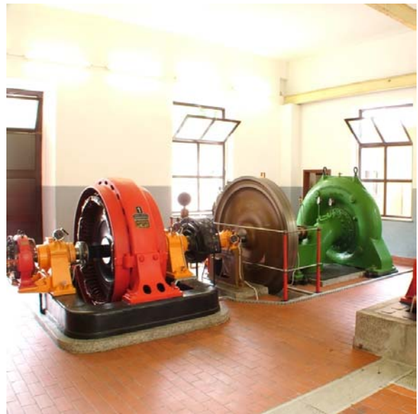
Slika 2: Notranjost strojnične zgradbe
