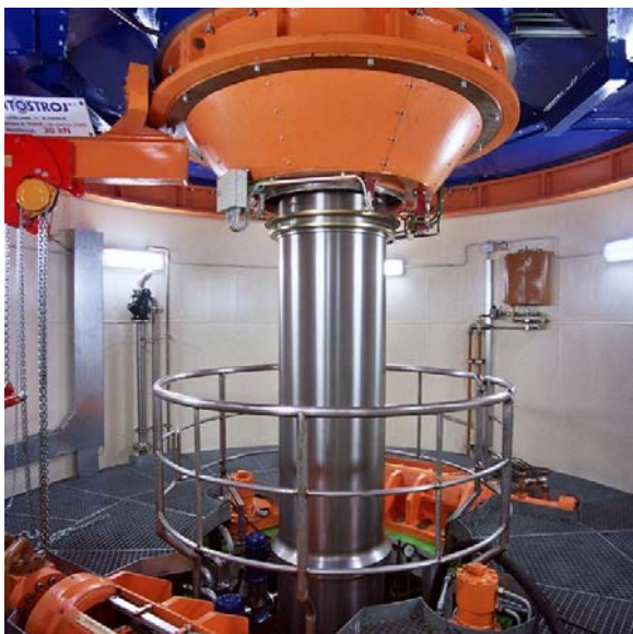
Slika 3: Gred generatorja
